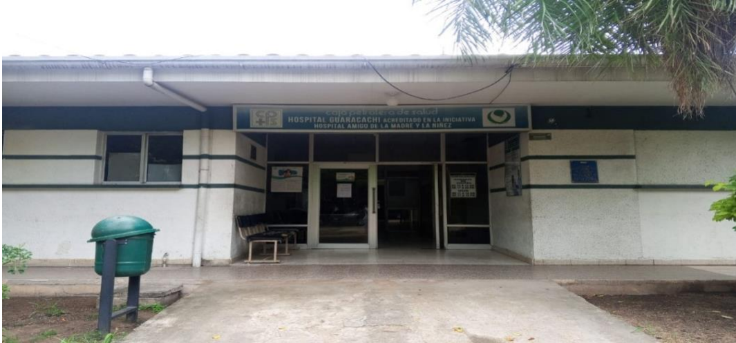
Imagen 3. Fachada principal Hospital Guaracachi
