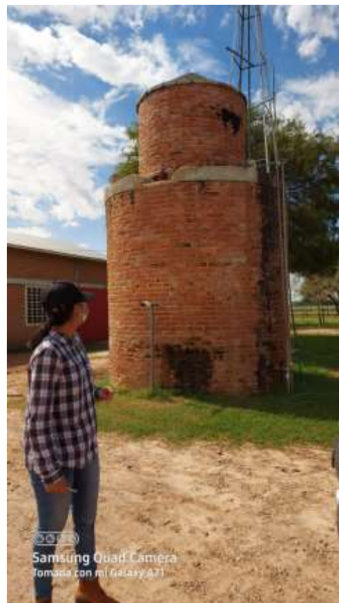
Anexo 10. Tanque de agua de mampostería.
