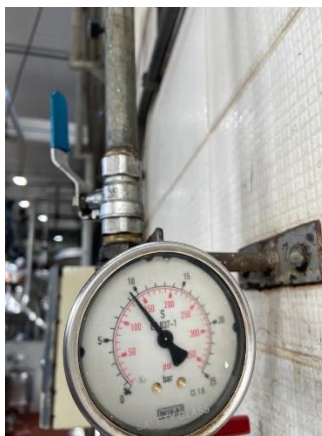
Fotografía 11: Verificación de la presión de aire de la pistola, Laura Duran (2023)
